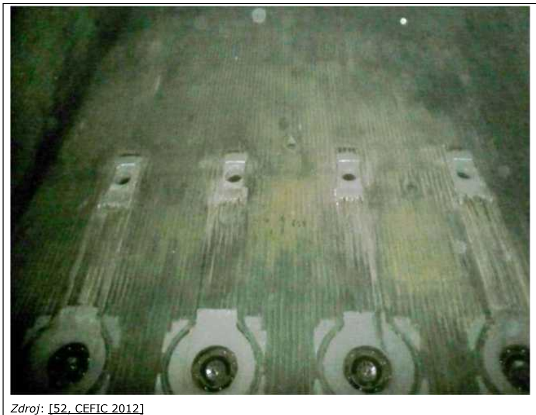
Obrázok 8.9: Technika nadmerného prívodu vzduchu dodatočne inštalovaná v kotle v chemickom zariadení
