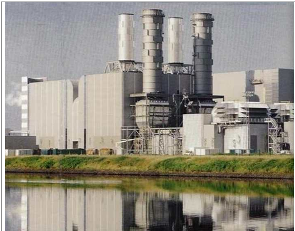
Obrázok 2.16: Nedávno postavená plynová turbína s kombinovaným cyklom v Belgicku
