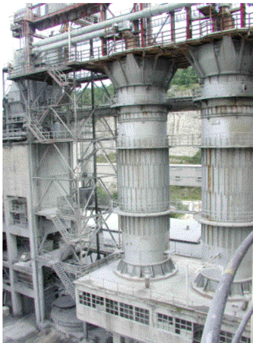
Obrázok 2.21: Šachtová pec s miešaným zavázaním
