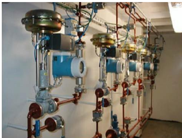
Obrázok 6.28: Meracia a dávkovacia stanica s pneumatickými ventilmi
