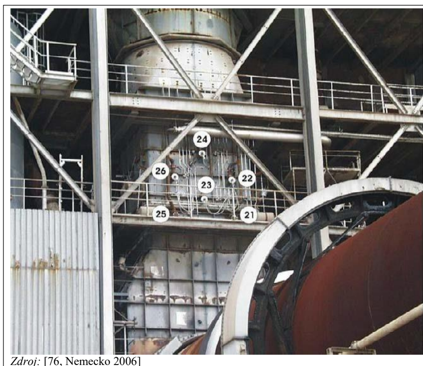
Obrázok 6.8: Vysokoúčinný systém SNCR a miesto na vstrekovanie amoniakovej vody cez vstrekovacie tyče na pozíciách od č. 21 do č. 26
