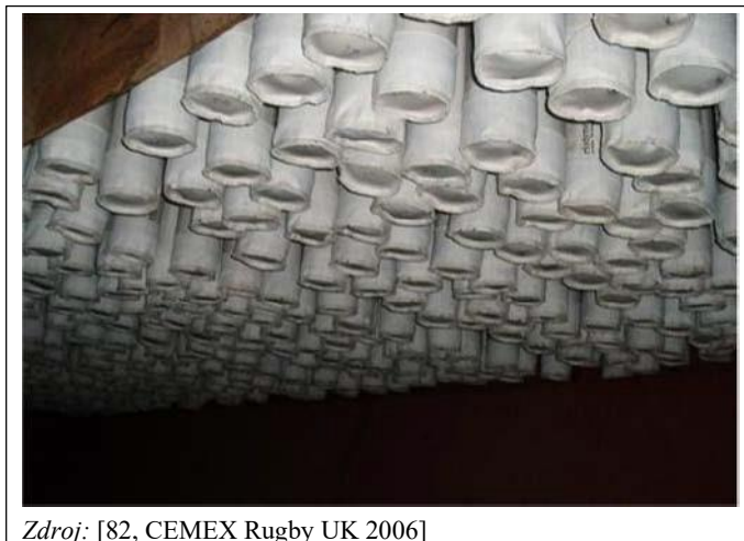
Obrázok 1.60: Príklad textilného filtra a filtračného materiálu používaného v cementárni v Spojenom kráľovstve
