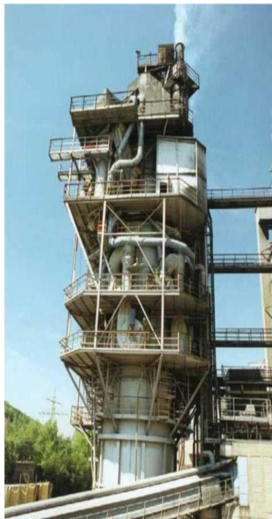
Obrázok 2.26: Príklad kruhovej šachtovej pece používanej pri výrobe vápna
