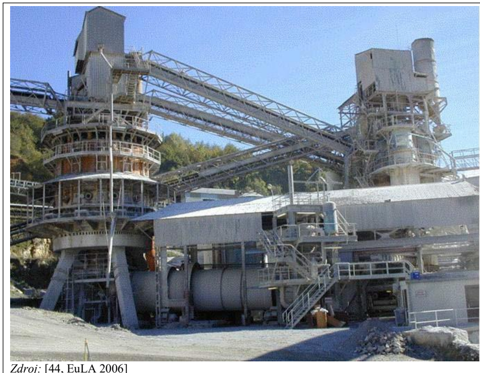
Obrázok 2.34: Príklad rotačnej pece s predohrievačom
