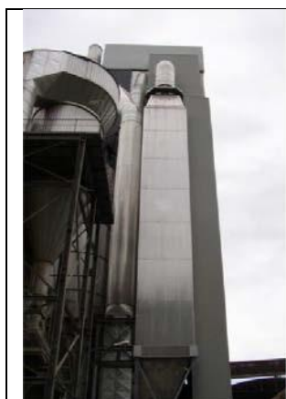
Obrázok 1.66: Príklad zariadenia SCR Zdroj: [140, Taliansko 2007]
