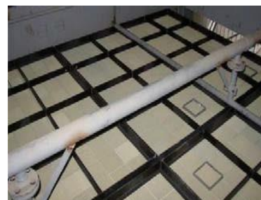
Obrázok 1.68: Príklad pozície modulu používaného pri technike SCR Zdroj: [140, Taliansko 2007]
