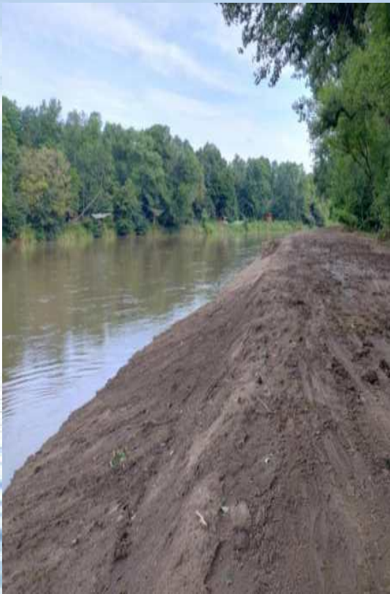
Odstránenie brehového opevnenia
