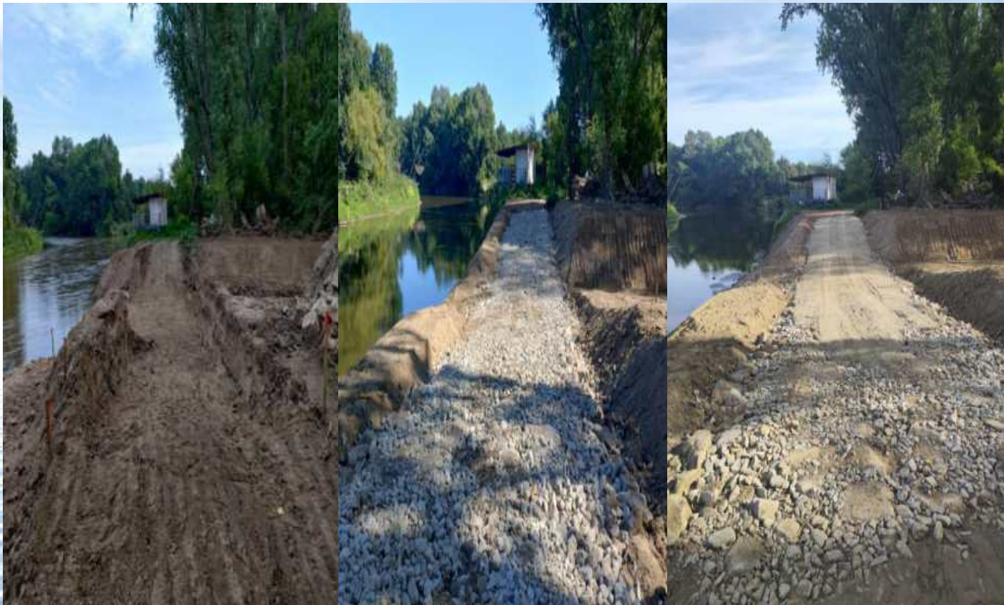
Zhotovenie brodu pri nátoku do ramena pre zachovanie miestnej komunikácie pozdĺž Moravy
