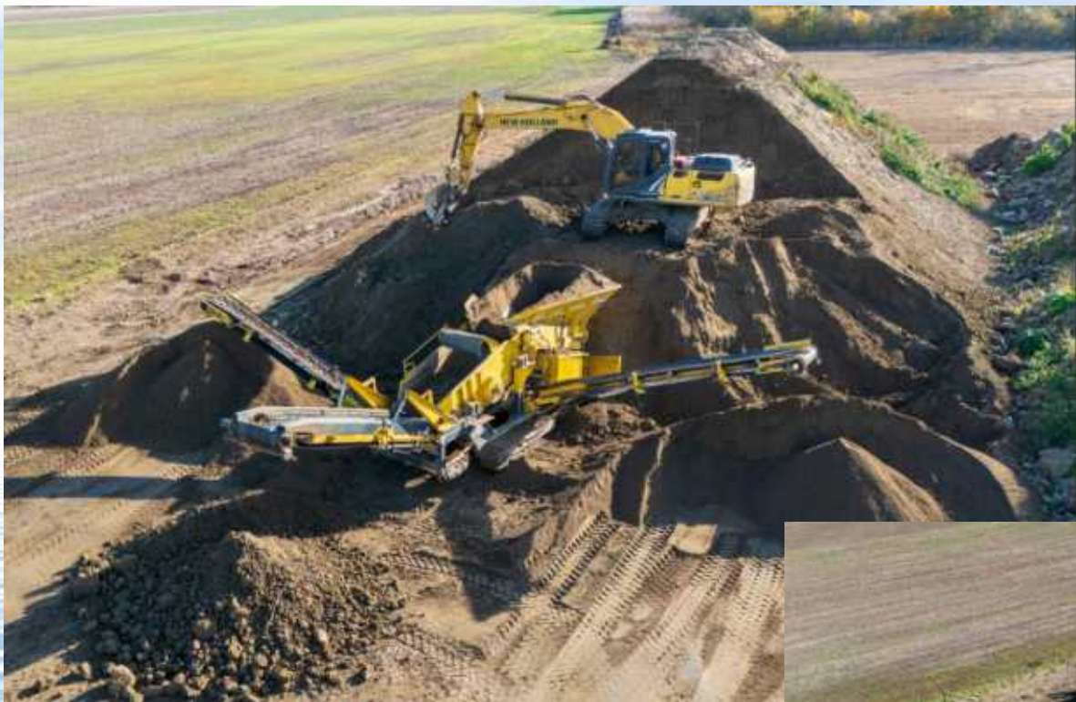
Triedenie odťazeného sedimentu
