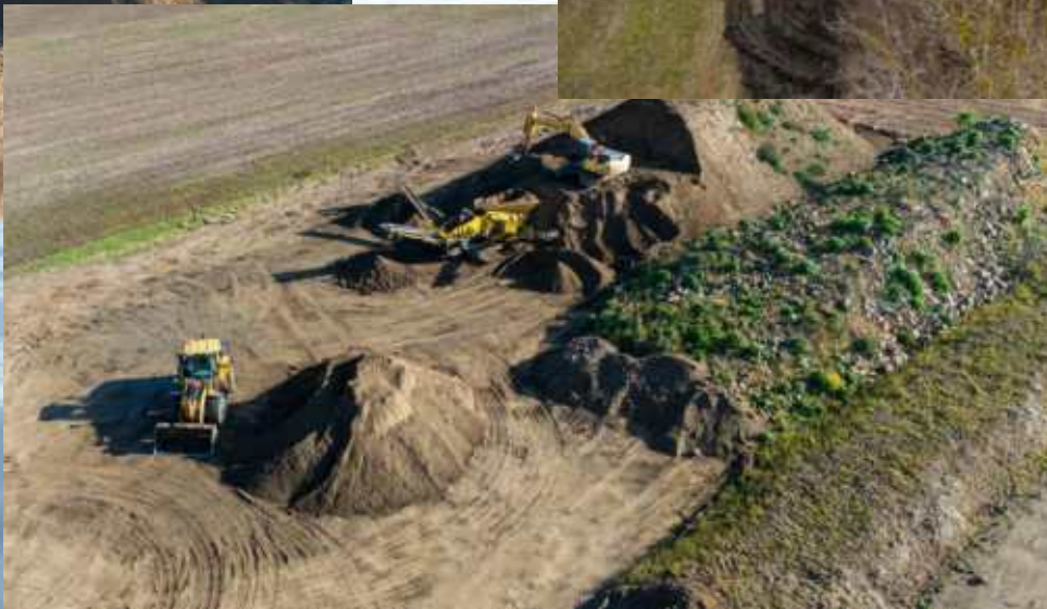
Triedenie odťazeného sedimentu
